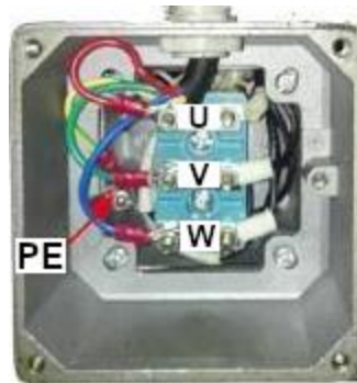
Рисунок 3.16 – Подключение электродвигателя
